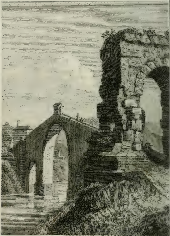
Malterische Ansicht der Brücke
